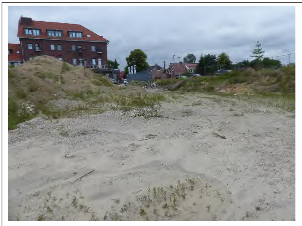
Foto 6: Blick über den nordwestlichen Grundstücksbereich., nördlich der Baugrube. Blickrichtung Westen. Der westliche Bereich des Geländes sowie die darauf befindlichen Gebäude (im Bild im Hintergrund: Gefriergebäude) sind bereits in Benutzung. Die Fahrwege und Parkplatzflächen sind dort gepflastert (12.06.2018).
