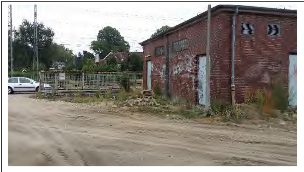
Foto 9: Nördlich der Milchverarbeitung befindet sich ein Trafogebäude entlang der Ausfahrt (09.08.2018).
